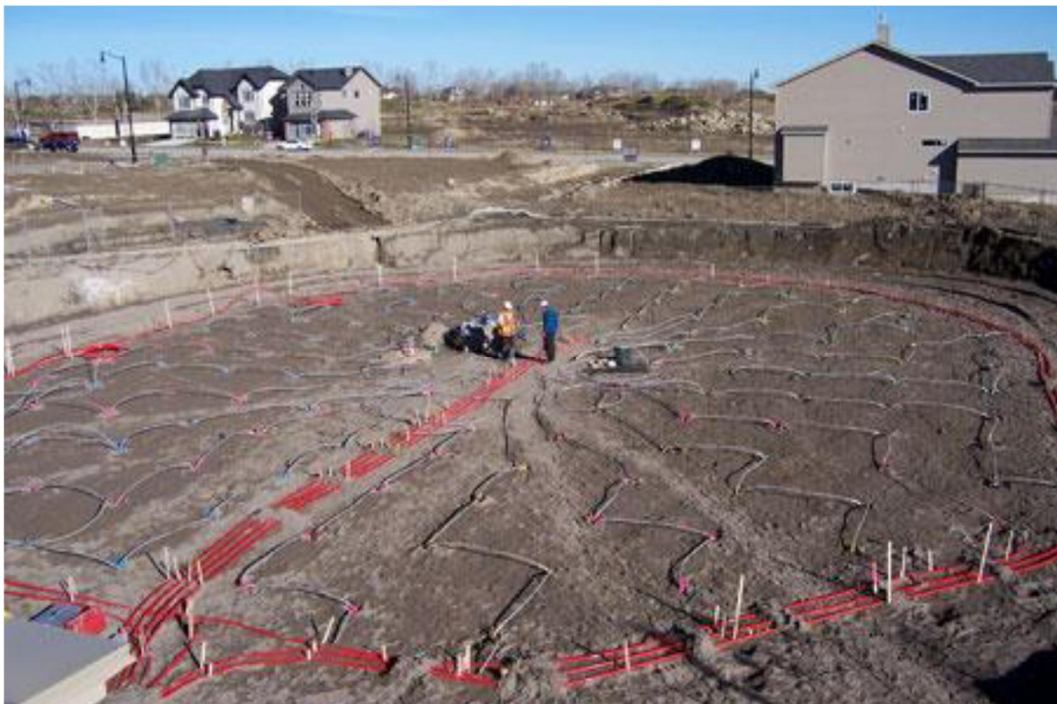
Figur 32 – Bilde fra konstruksjon/etablering av brønnparken i Drake Landing i Canada. (Kilde: dlsc.ca)
