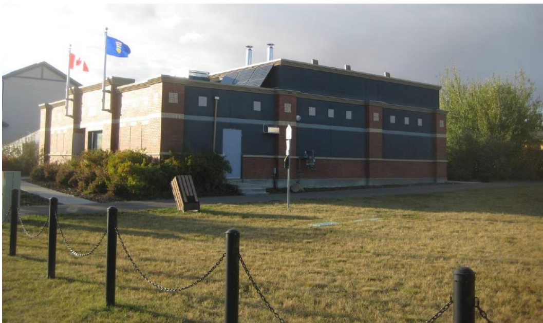
Figur 33 – Bearbeidet terreng kan etter etablering av brønnpark benyttes til de fleste typer formål, som for eksempel parkering, idrett, gressbane, e.l. Her vises slikt terreng over et sesonglager (McClenahan, 2015).
